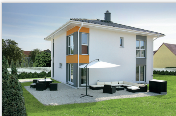
Danwood, Park 169W. Dom dwukondygnacyjny. Na parterze znajduje się pokój dzienny z jadalnią i otwartą kuchnią, spiżarnia, pokój gościnnie, WC oraz pomieszczenie techniczne, na piętrze – pokój z garderobą, dwa pokoje z wspólną garderobą i łazienka. Dach kopertowy o nachyleniu 22°. Powierzchnia: 164,84 m 2 .
